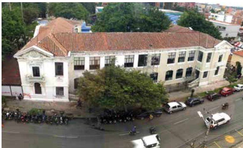
Imagen 25. Resane y pintura general de la UPN
