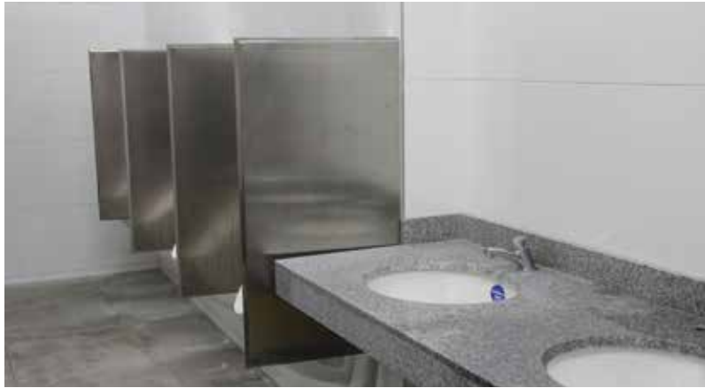
Imagen 29. Nuevas baterías sanitarias
