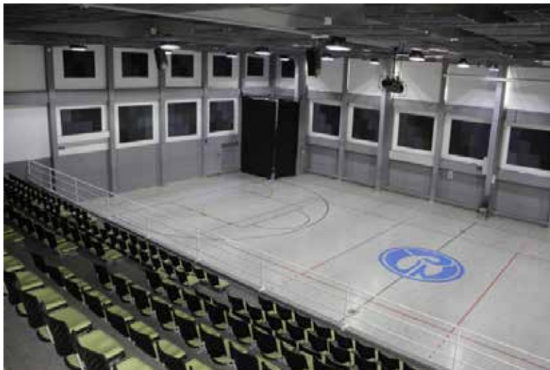
Imagen 34. Instalación de silletería en graderías en Auditorio Multipropósito
